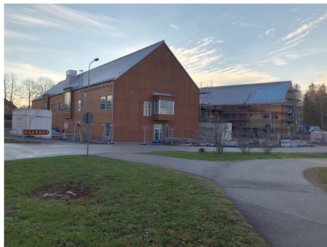
Påbörjad högstadieskola i Färjestaden.
